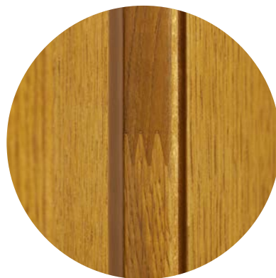
Różnice kolorystyczne łączeń**
